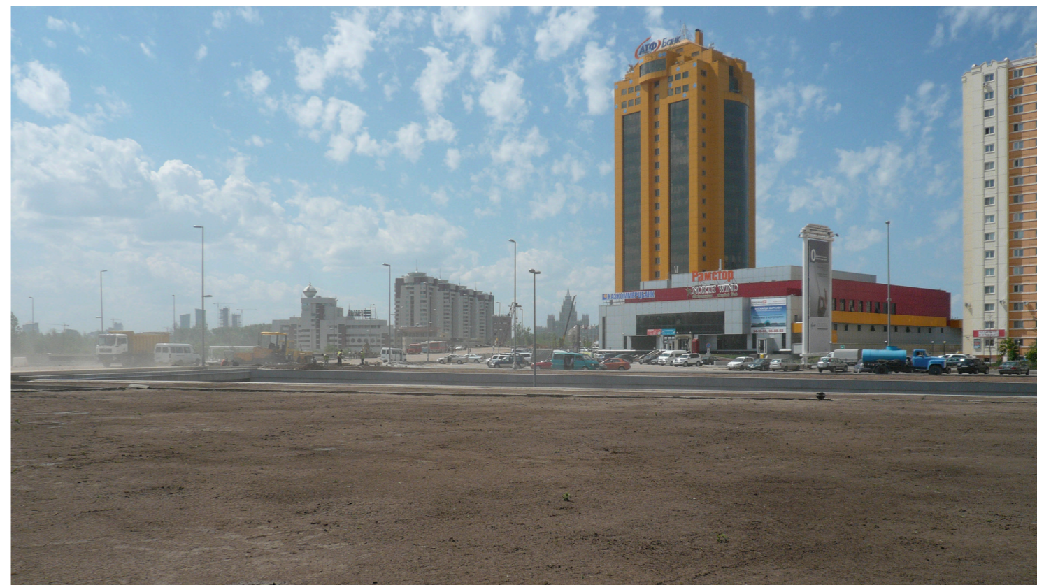
'Ramstore' shoppingcenteret og 'Gulerodsbygningen' syd for floden Ishim floden. Til venstre for Gulerodstårnet skimtes konturen af den nye regeringsby.
