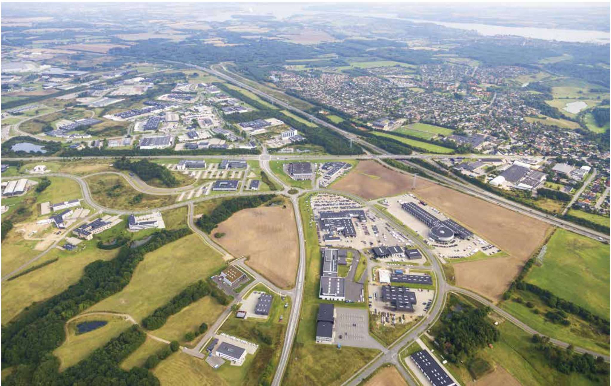
Luftfoto fra september 2013 af det finmaskede naturnetværk ved Bramdrupdam/Pedersminde nordvest for Kolding. Her har Kolding Kommune forsøgt, at integrere naturnetværkets vandsystem og beskyttelsen af fremtidige drikkevandsreserver med udstykning af et nyt industrivarter.
