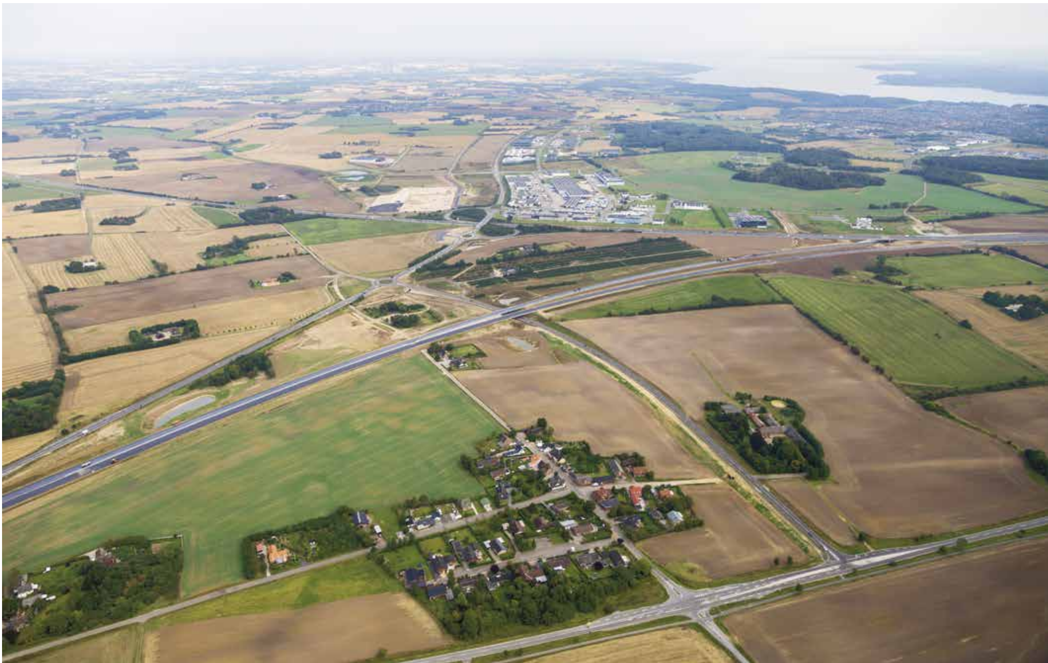
Luftfoto fra september 2013 af Den Midtjyske Motorvejs sammenfletning med E45 ved Danmarks Transport Center, DTC nord for Vejle. Det er umuligt at se i dag, men industrikvarteret ved DTC er udspring for de to ådale som løber ud i Vejle Fjord øst og vest for Bredballe.
