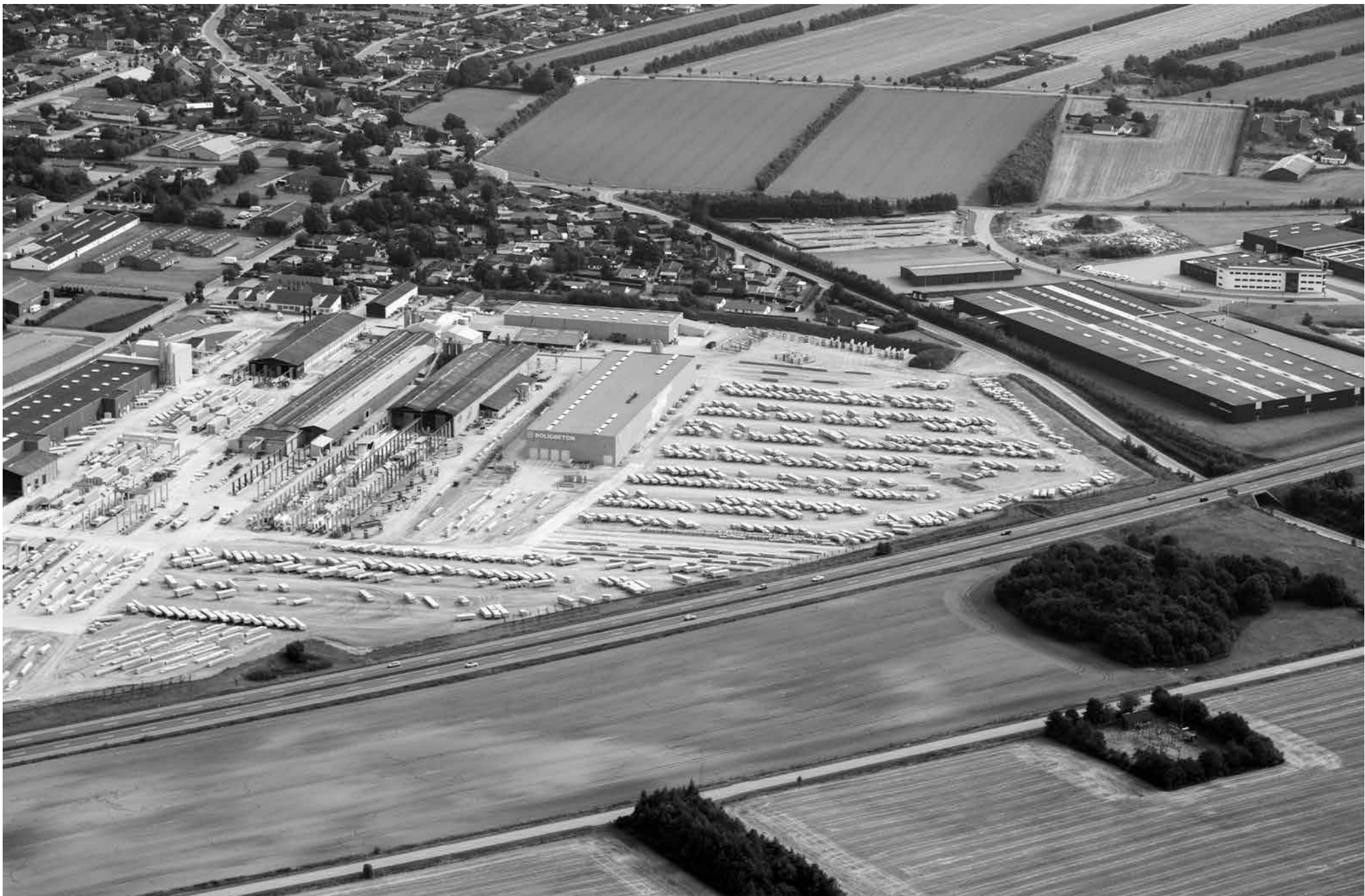
Fig 2. Luftfoto af A/S Boligbeton, 2016. (Foto: Boris Broman Jensen)
