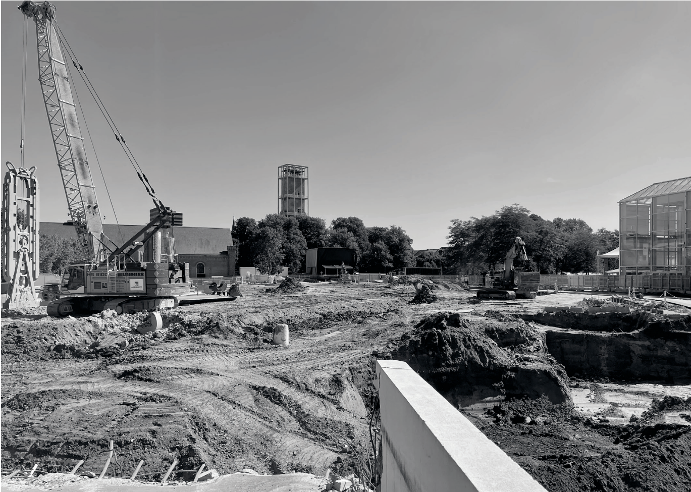
Udgravning til den forestående udvidelse, 'The Next Level', august 2022. Foto: Boris Brorman Jensen
