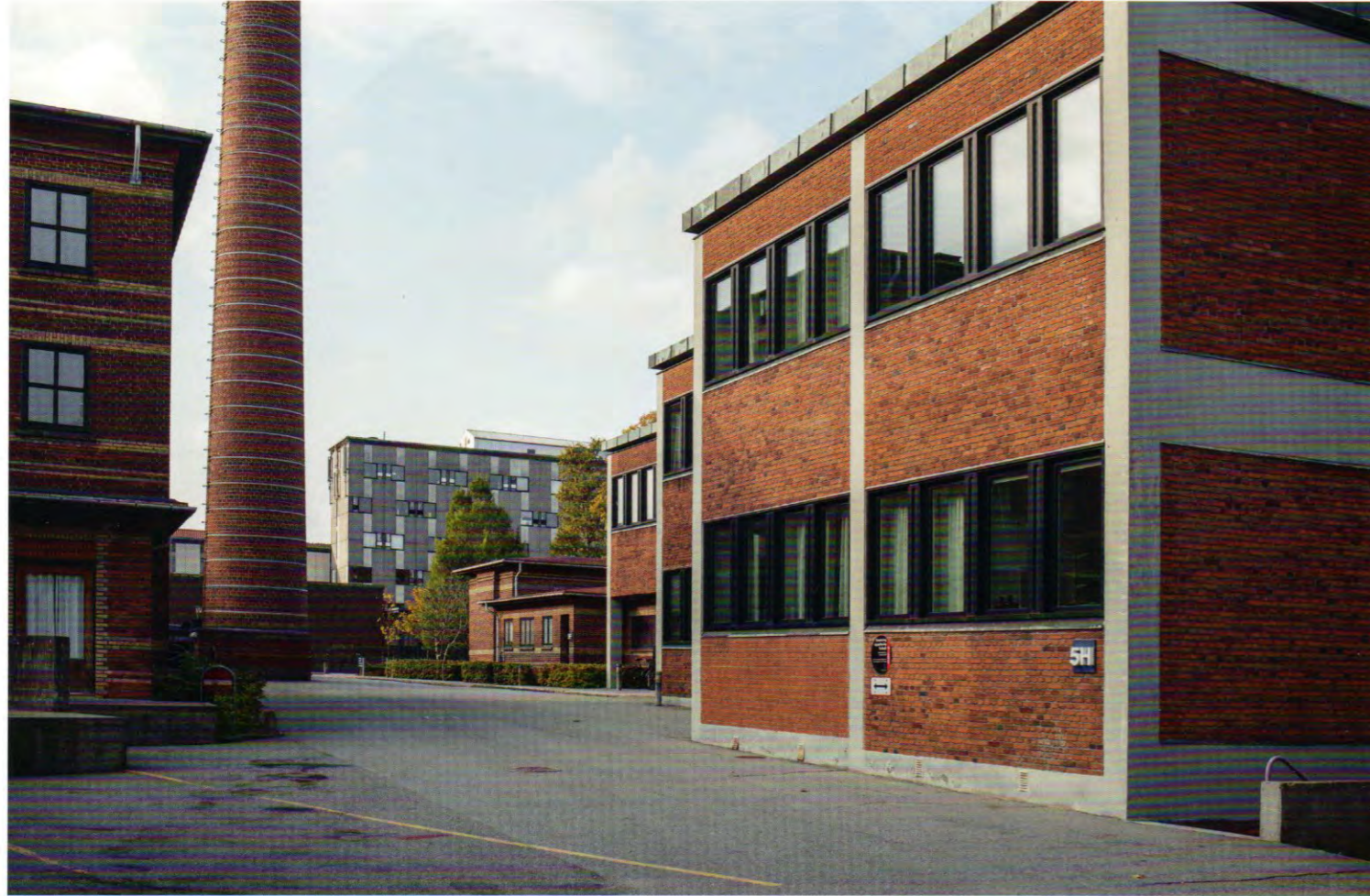
Patologisk afdeling til højre tegnet af arkitekt Harald Salling-Mortensen (ca. 1969). Planlægges nedrevet. Foto: Helene Høyer Mikkelsen (2015)
