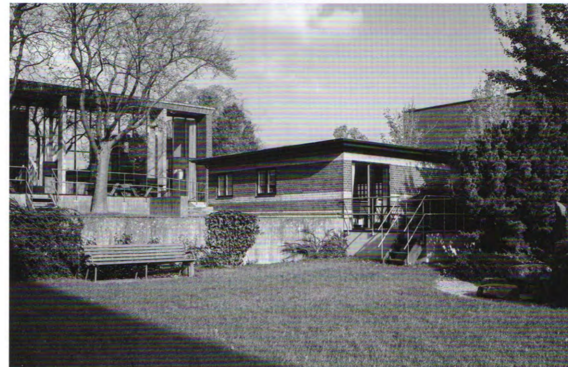
Kantine til venstre tegnet af Harald Salling-Mortensen (ca. 1966). Planlægges nedrevet. Til højre den oprindelige kiosk tegnet af Axel Høeg-Hansen (1898). Planlægges bevaret. Foto: Helene Høyer Mikkelsen (2015)
