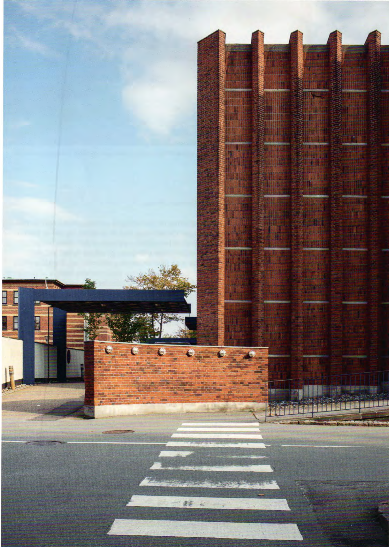
Behandlingsbygning Øst og Vest tegnet af Harald Salling-Mortensen (ca. 1972). Planlægges nedrevet. Foto: Helene Høyer Mikkelsen (2015)
