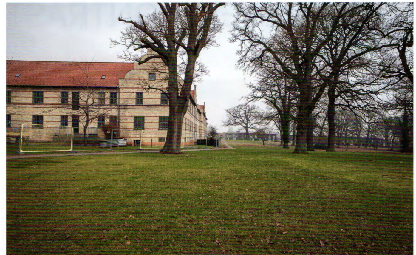
M.G. Bindsbølls hovedbygning til venstre (1852). I baggrunden nye rækkehuse. Foto: Helene Høyer Mikkelsen (2023)
